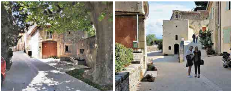
1/ Étroites et typiques des petits villages de charme, les ruelles ont été revêtues de macro-béton, appelé aussi 'béton caladé' en raison des granulats grossiers qui le composent (Ø 2,5 cm et au-delà), et de pavés (10 x 10 cm). 2/ En pied de façades, les massifs, entretenus par la population, ont été conservés. Parmi les essences plantées, d'inspiration méditerranéenne, on peut citer des lauriers 'in', des cistes, des pittosporums, des filaires, des sauges...
