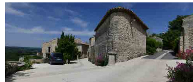
↑ l'utilisation du béton désactivé est restreinte au profit de l'enrobé mais significative puisque localisée aux entrées du village
