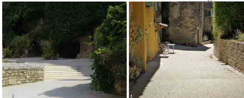
3/ Autour de la grotte, des gradins en pierre et béton aspect calcaire ont été disposés pour former un petit 'théâtre'. 4/ Les seuils des résidences, véritables connexions entre l'espace privé et public, ont été traités en béton décoratif. La granulométrie est fine et la couleur identique aux pavés et aux pierres.
